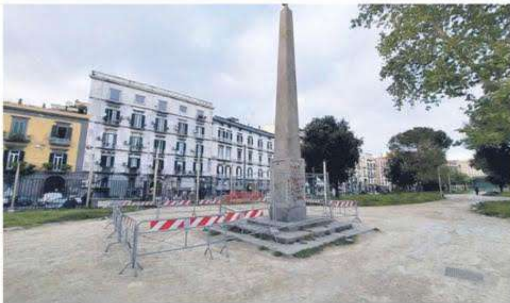
LAVORI L'obelisco della meridiana in Villa comunale: "Friends of Naples" che si occupa di restaurare monumenti ecclesiastici e laici ne finanzia il recupero
